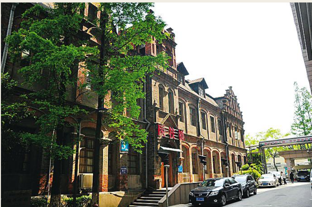
湖州女校教学楼（俗称红房子，现湖州第一医院医技楼）
